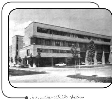
ساختمان دانشکده مهندسی برق
