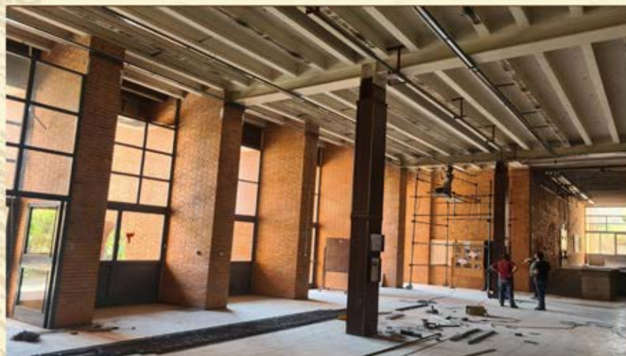
بازسازی ساختمان ابن سینا - ۱۴۰۲
