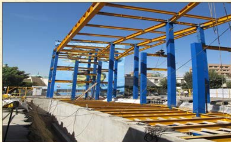
عملیات عمرانی ساخت سر در دانشگاه - ۱۳۹۶
