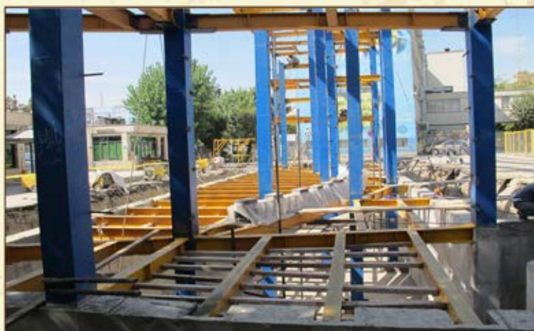
عملیات عمرانی ساخت سر در دانشگاه - ۱۳۹۶
