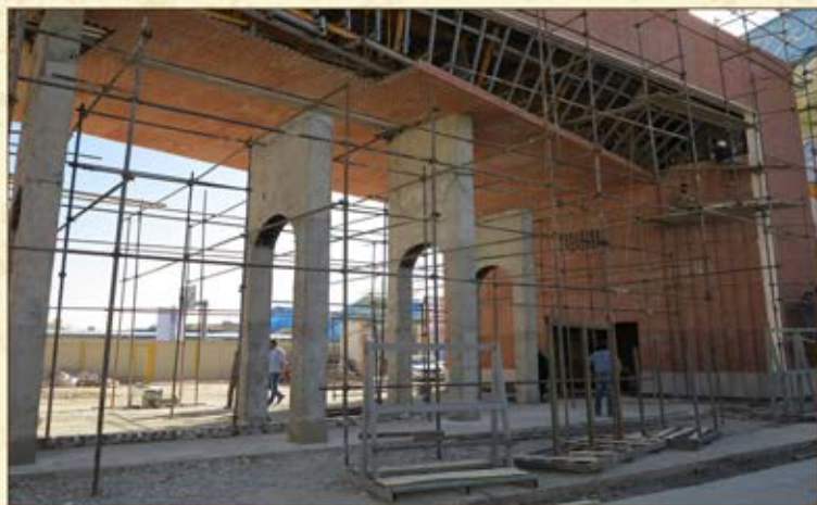
عملیات عمرانی ساخت سر در دانشگاه - ۱۳۹۶
