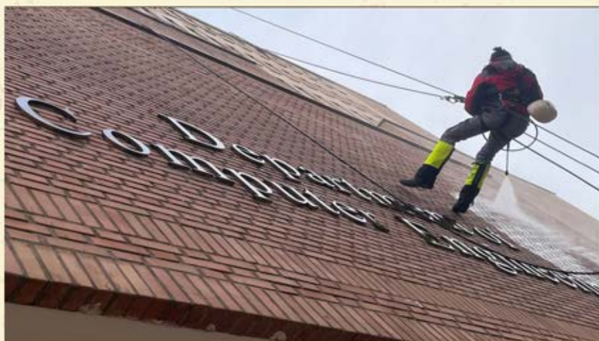
شست و شوی نمای ساختمان کامپیوتر - ۱۴۰۳
